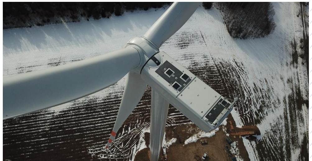
Project Ciekocinko. De koolstofintensiteit in Polen in 2020 is 710 gCO 2 e/kWh vergeleken met gemiddelde Europese intensiteit van 231gCO 2 e/kWh. Het land heeft hernieuwbare energieprojecten nodig omdat de energiemarkt wordt gedomineerd door steenkoolproducten.
